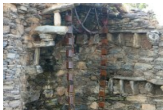
Собственно механизм подъёма воды
