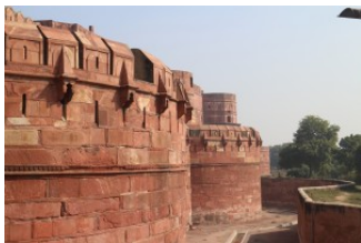
Стена, вид снаружи
